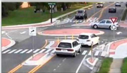
Sample Mountable Curb Mini Roundabout
